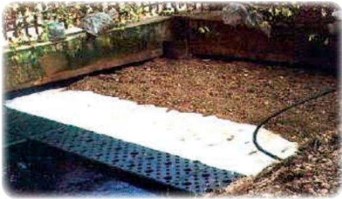
**Figura 5 – Strati della copertura biofiltrante (in opera).**
