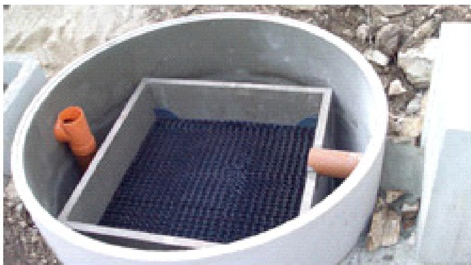
**Figura 4 – Particolare costruttivo di un reattore modulare.**
